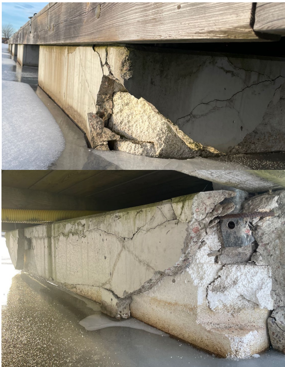
Figur 24: Bilder på flytelement vars skyddande lager gått sönder. Siljan. Foto: Havsmiljöinstitutet.
