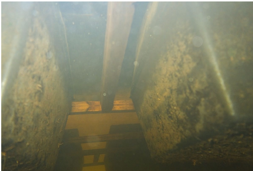
Figur 23: Undersidan av en flytbrygga med helt inkapslade flytelement. Delsjön. Foto: Havsmiljöinstitutet.
