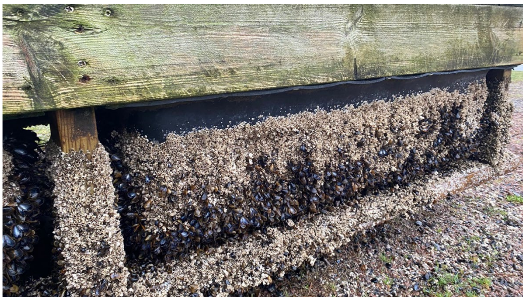
Figur 21: En flytbrygga i Gullmarsfjorden, upptagen på land. Bilden visar kraftig påväxt av blåmusslor och havstulpaner. Foto: Havsmiljöinstitutet.
