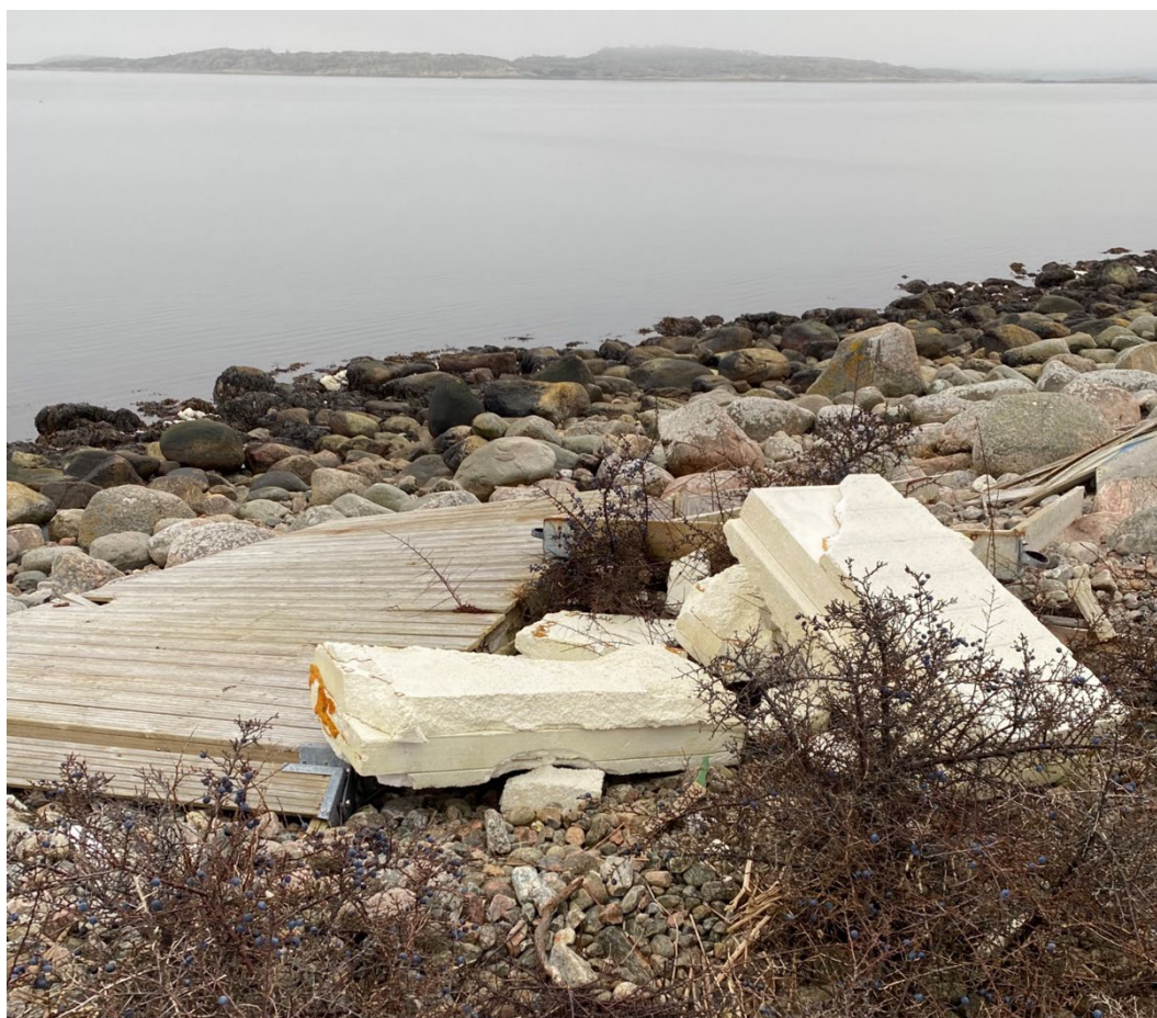
Figur 25: En flytbrygga som spolats upp utanför Kungälv. Bilden visar lösa frigolitblock och träplank. Foto: Västkuststiftelsens arkiv.
